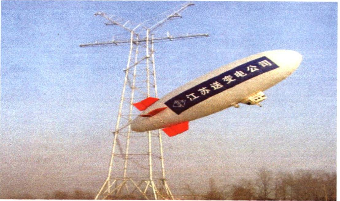
2002年12月在220千伏石扬夹江跨越工程第一次使用氦气飞艇架线
