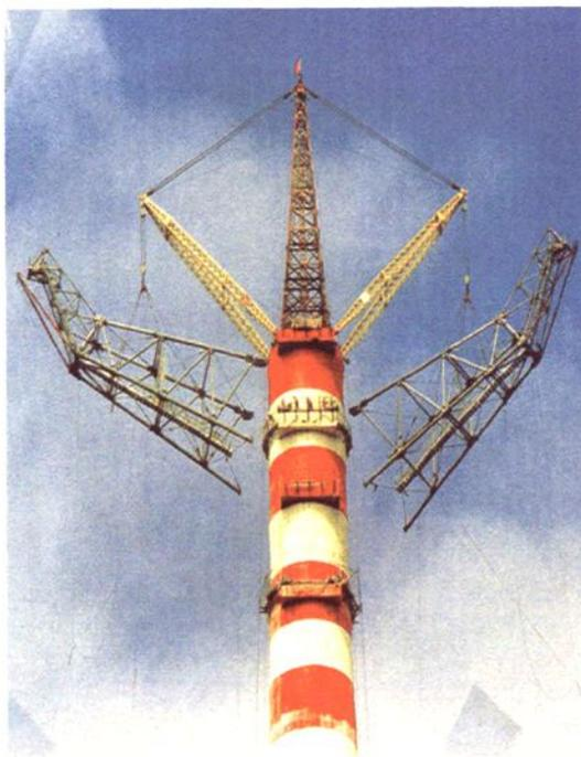
500千伏南京大胜关长江大跨越257米钢筋混凝土输电塔头吊装
