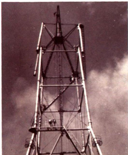
1975年自行设计和制造的“多臂自升悬浮扒杆”在吊装作业
