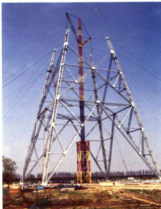
2002年正在施工中的500千伏江阴长江大跨越工程跨越塔为格构式型钢双回路角钢塔，塔高346.5米，为同类型塔世界之最
