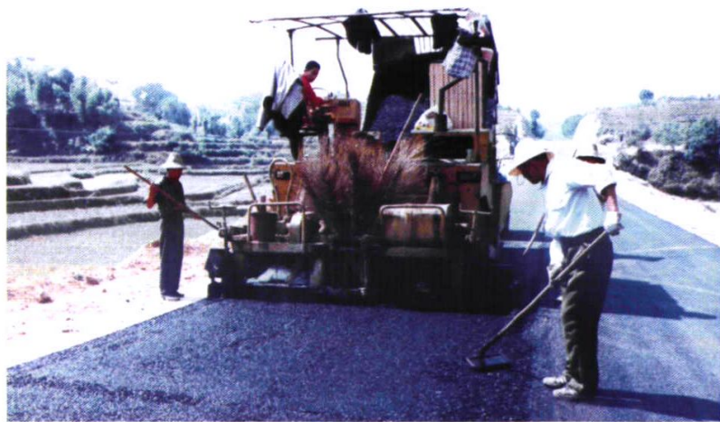
◀ 机械摊铺沥青路
