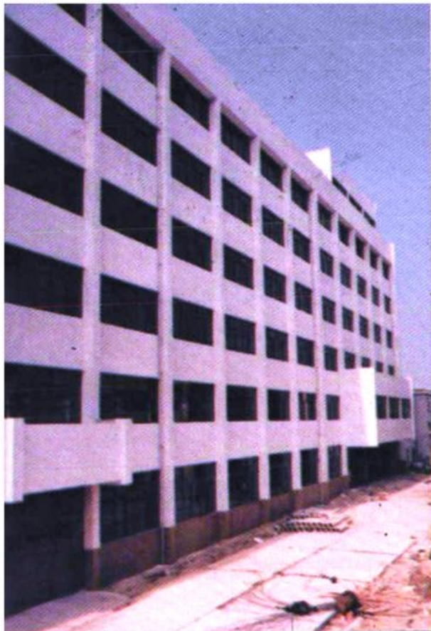
19. 武汉市无线电二厂新建的 总装大楼
