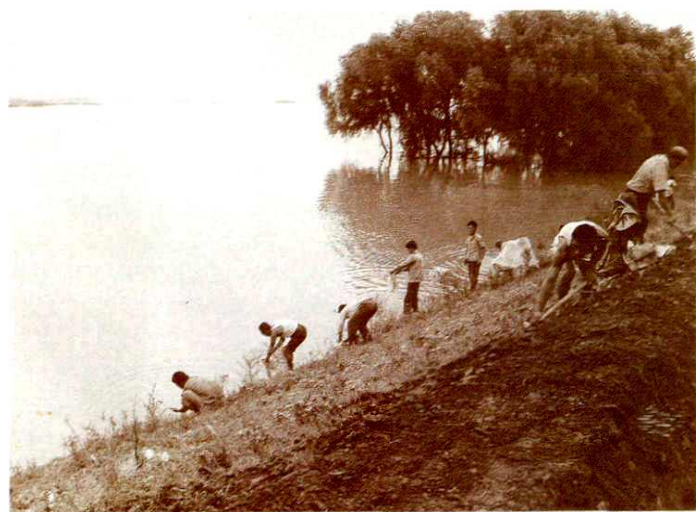
台安县民工抢修堤坝
