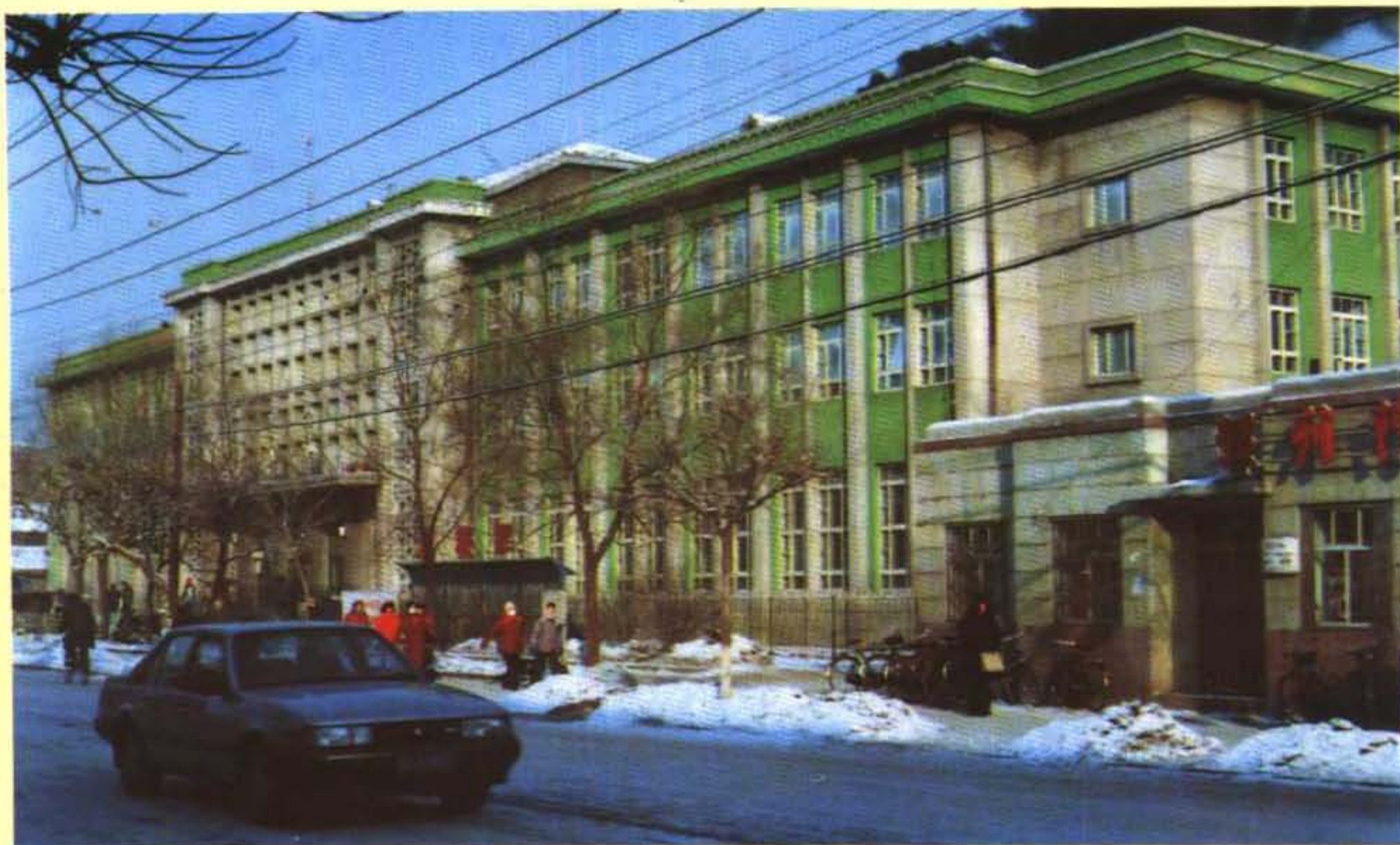
吉林市邮电局办公楼（1985年）
