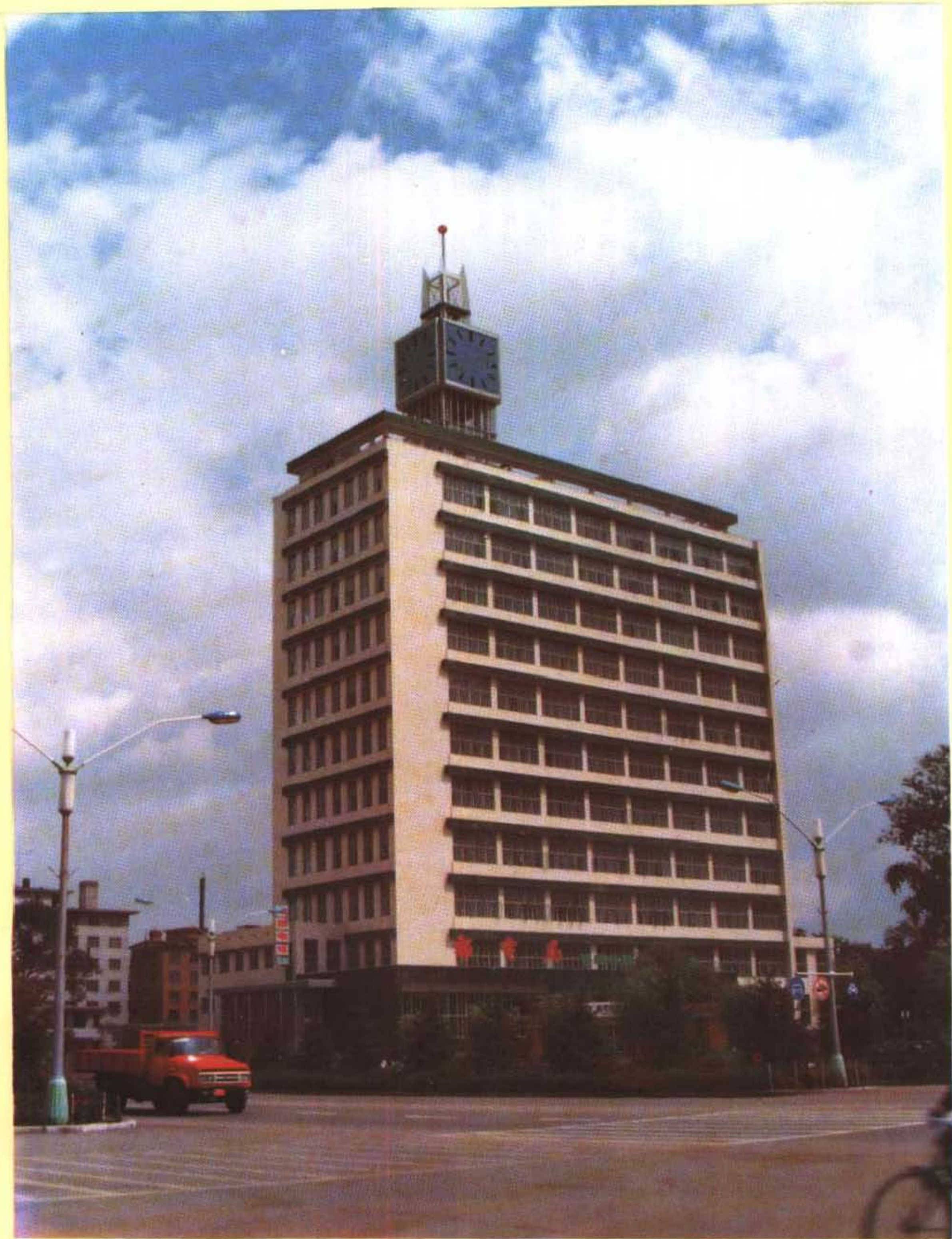
1985 年建设中的吉林通信枢纽大楼（吉林大街 1 号）
