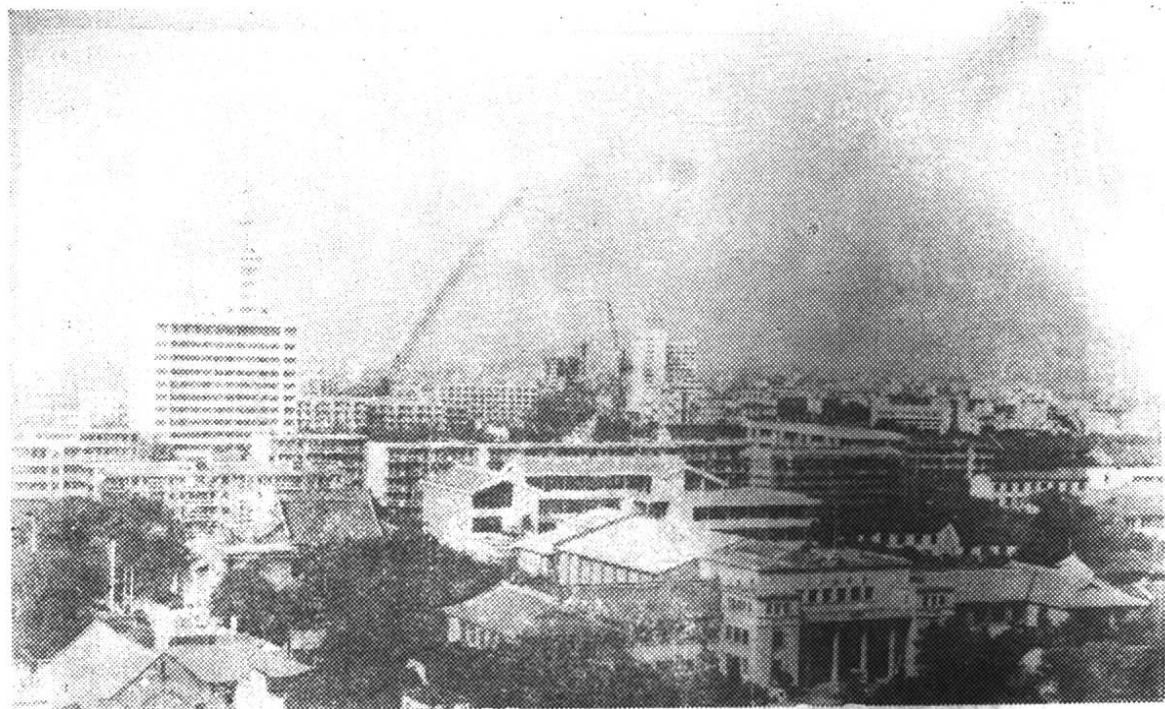
常州在建设中（1985年）
