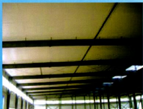
正在抓紧施工的主厂房
