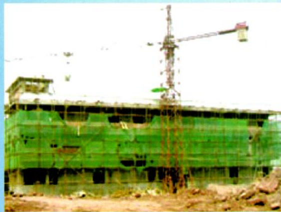
即将竣工的办公大楼
