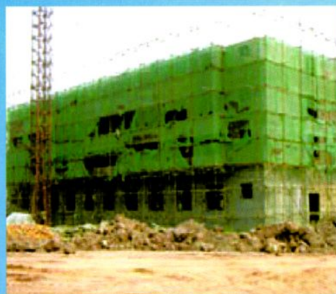
建设中的宿舍大楼
