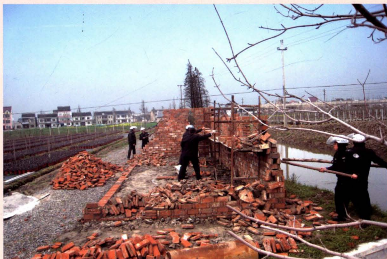
独山港镇拆除违法用地建筑现场
