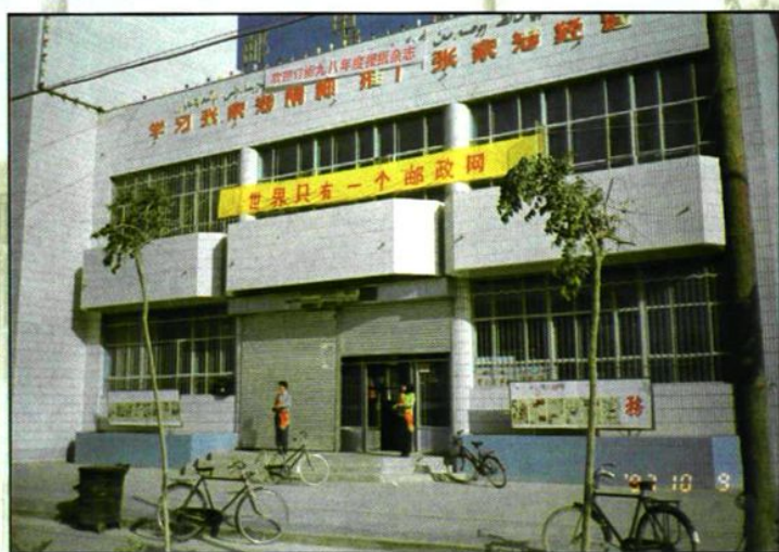
县局邮电大楼
