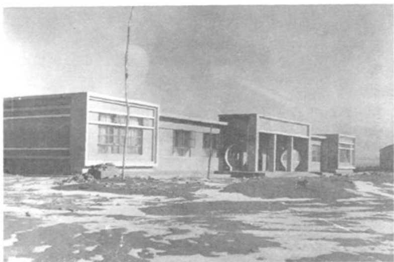
建设中的杭锦旗交通监理站办公室
