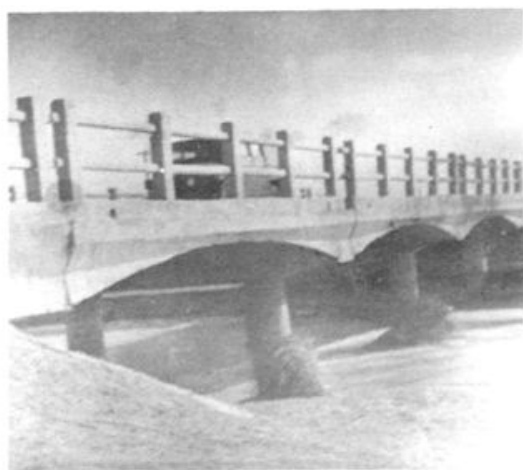
建永公路马头湾大桥侧面图是沿河较大的一座桥
