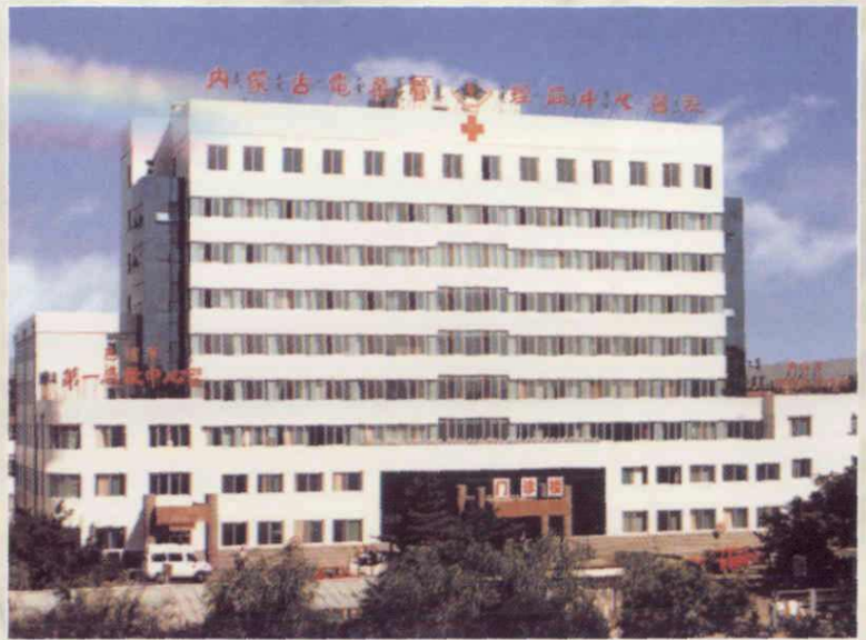
1995年建起的医院门诊大楼
