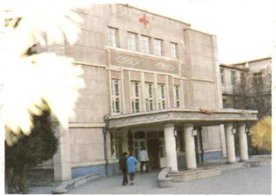
原建工部二局医院的门诊、病房连体楼(图为门诊前厅)
