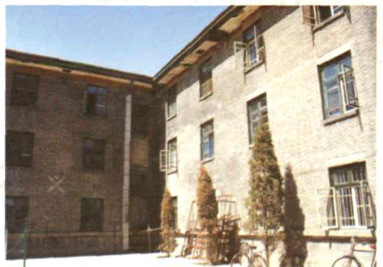
医院迁往包头后驻东河区巴彦塔拉大街旧址(后在两侧又接出的病房)
