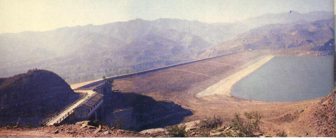
文峪河水库(上) 唐明摄 文峪河水库大坝施工现场(下) 史平供稿
