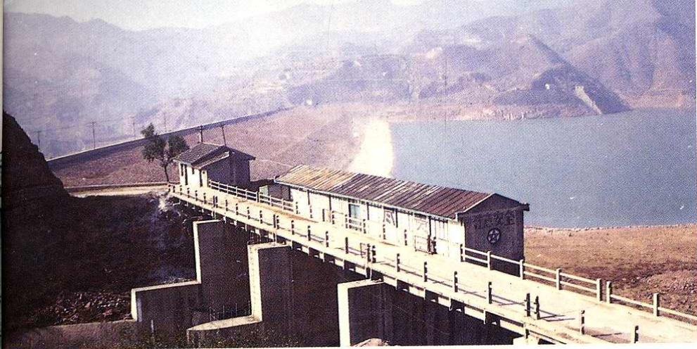
文峪水库溢洪道桥闸 唐明摄
