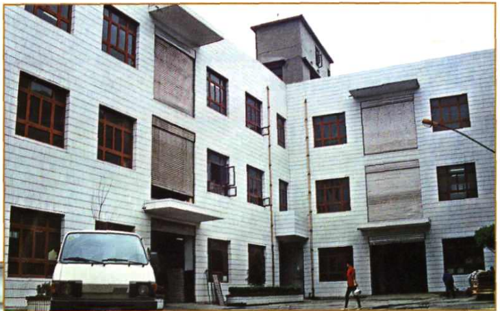
贵定印刷厂新建车间
