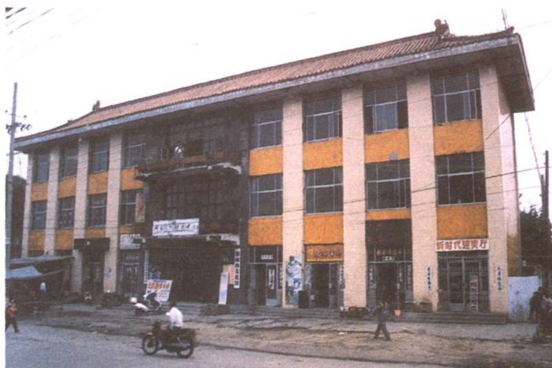
文化馆大楼外景
