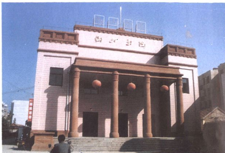
改造后的钢山剧院外景
