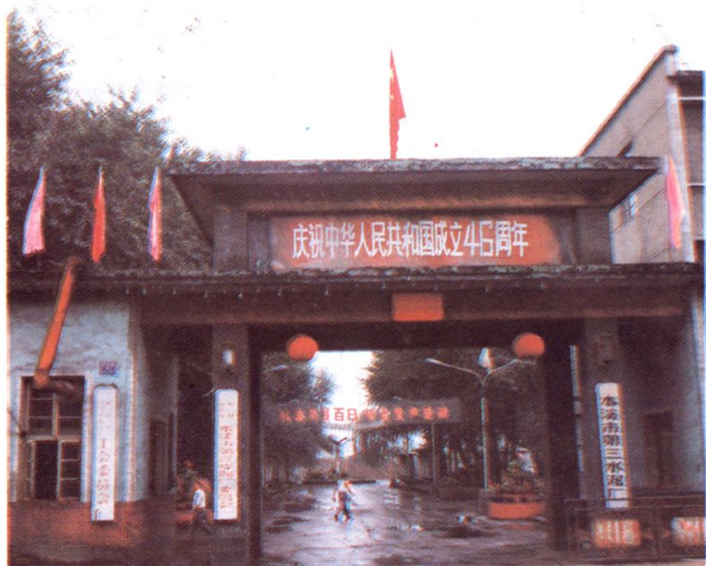
本溪市第三水泥厂正门
