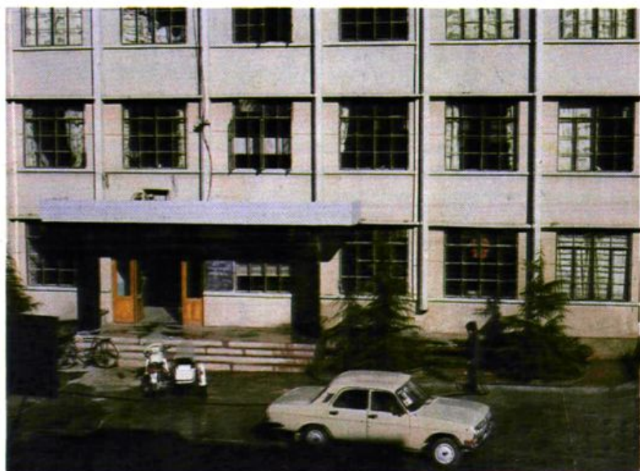
費县工商行政管理局費城所办公楼
