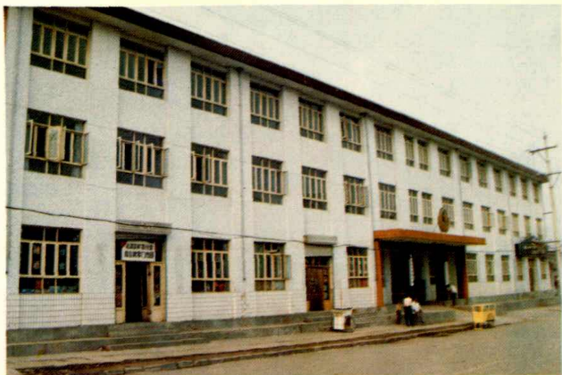
县人武部办公大楼
