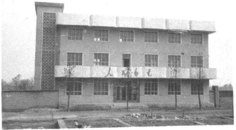
▷ 邮电支局大楼
