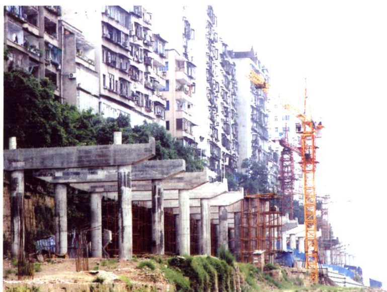
正在建设中的渠城渠江东西堤岸建设工程
