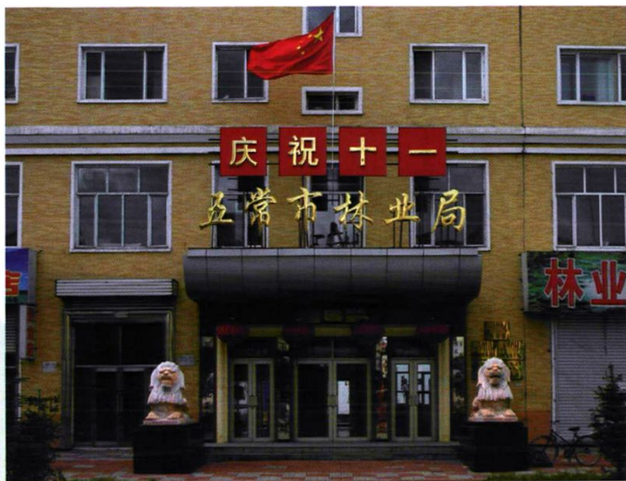
林业局综合办公楼正门
