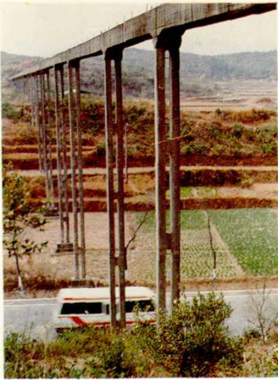
▲ 房溪水库跨怀一安公路高排架渡槽
