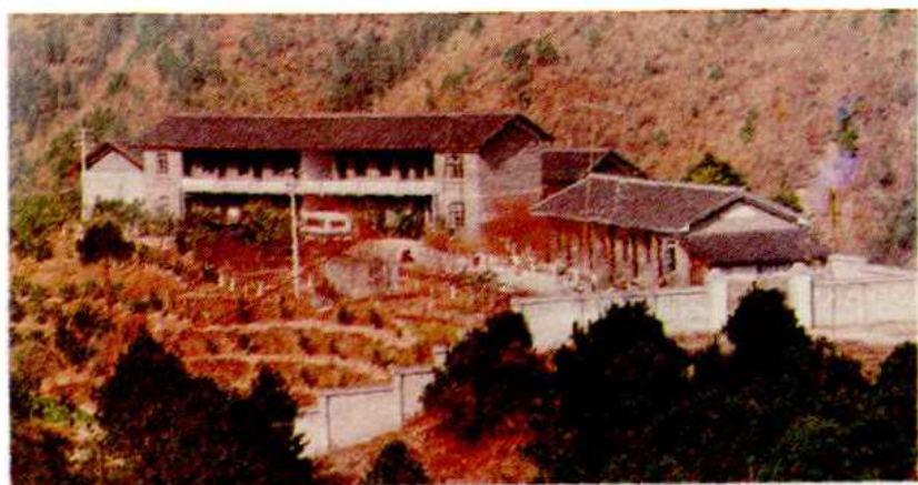
▲ 五龙溪中型水库管理站
