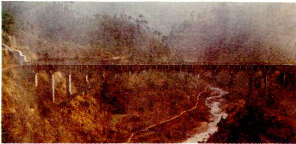
▲ 云空单拱渡槽连倒虹吸管
