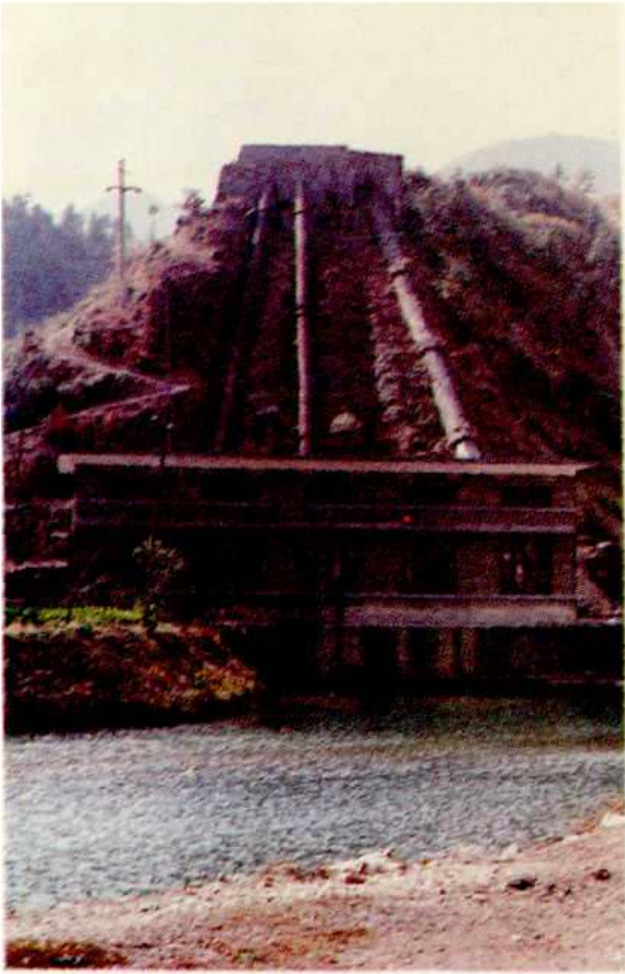
◀ 五龙溪水库三星桥渠道跌水电站
