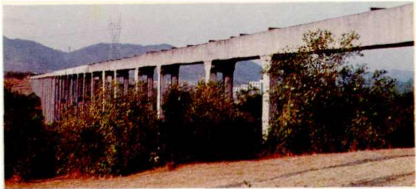
▲ 三里平湖长750米的渡槽
