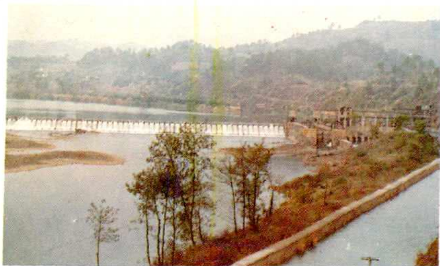
▲ 红岩水轮泵薄壳空心平板拦河坝
