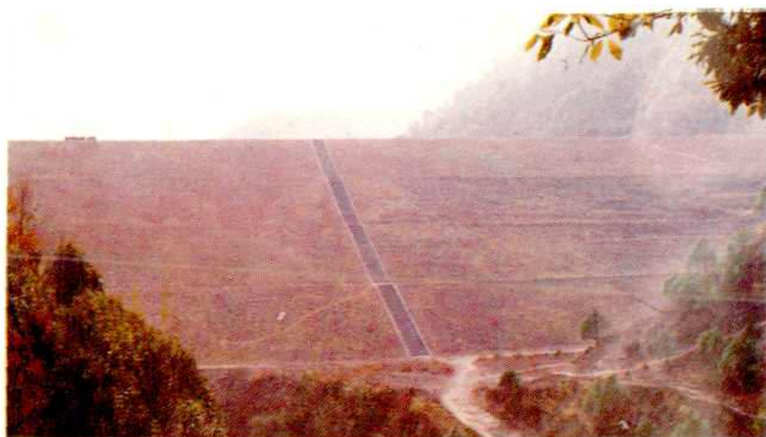
▲ 五龙溪中型水库心埤土质坝
