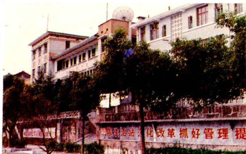
▲ 红岩电站办公大楼
