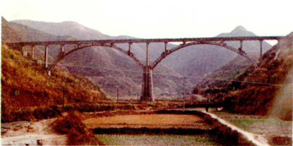
▲ 芦回溪钢筋混凝土双拱渡槽
