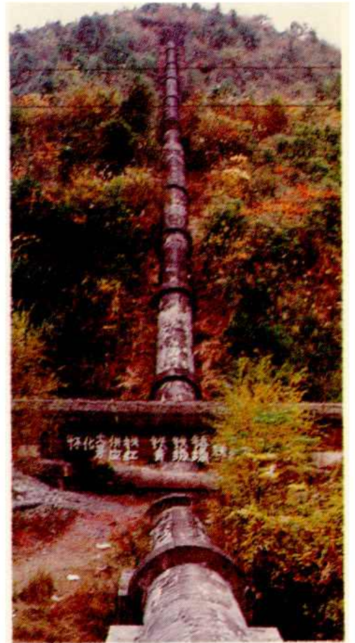
▲ 顺溪铺穿铁道倒虹吸管
