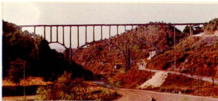
▲ 黄泥江岩拱排架复合渡槽
