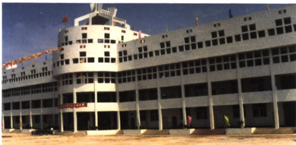
潮阳谷饶中学教学大楼。
