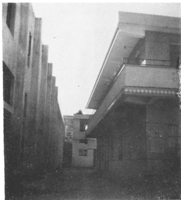
鹤庆县印刷厂新建的生产厂房。
