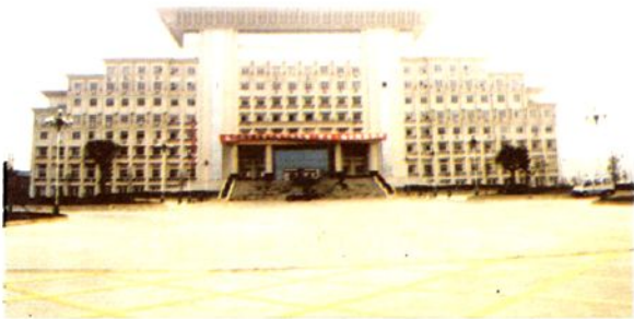
第二行政大楼(部门综合大楼)北大门 (丰城市文化局在五楼西侧办公)
