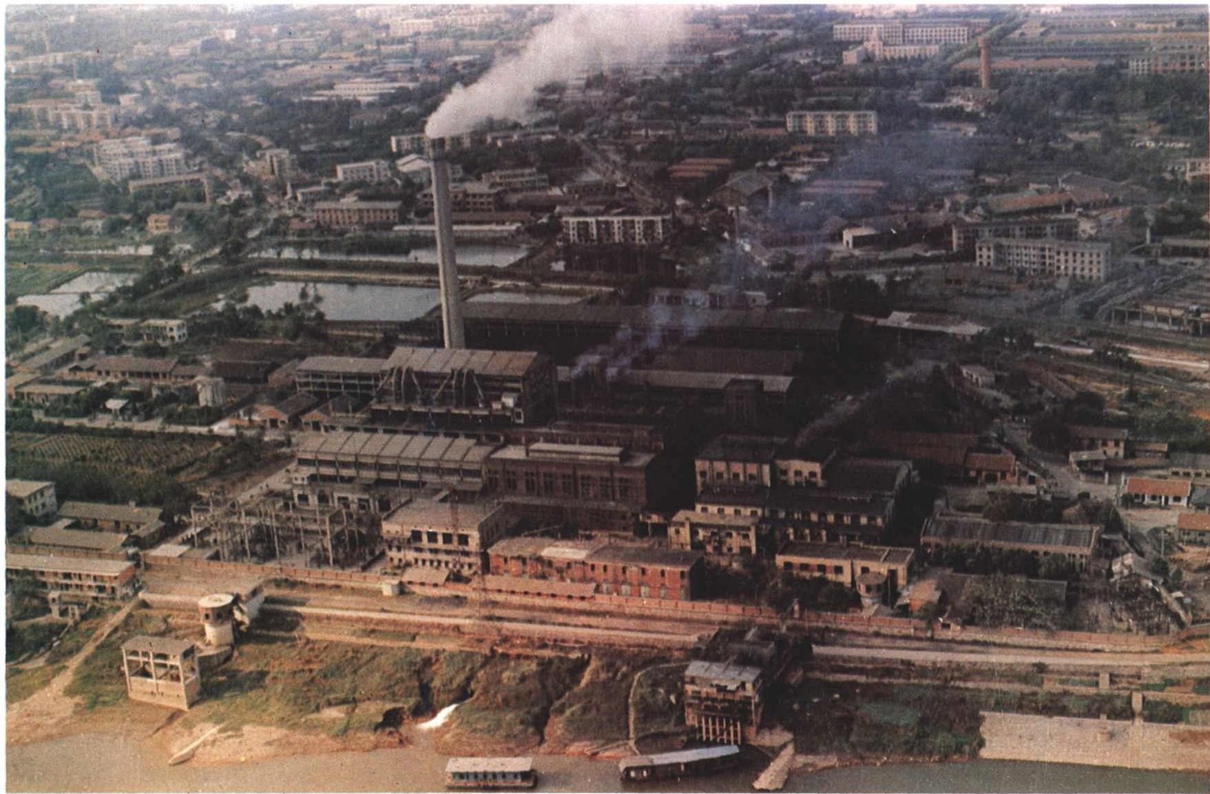
湘潭电厂全貌
