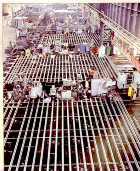
攀矿公司基建队伍在攀钢二期轨梁厂施工
