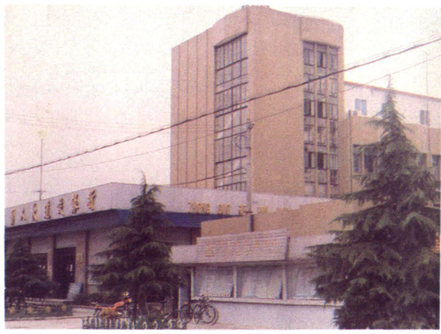
金山县建设银行办公大楼及营业部。
