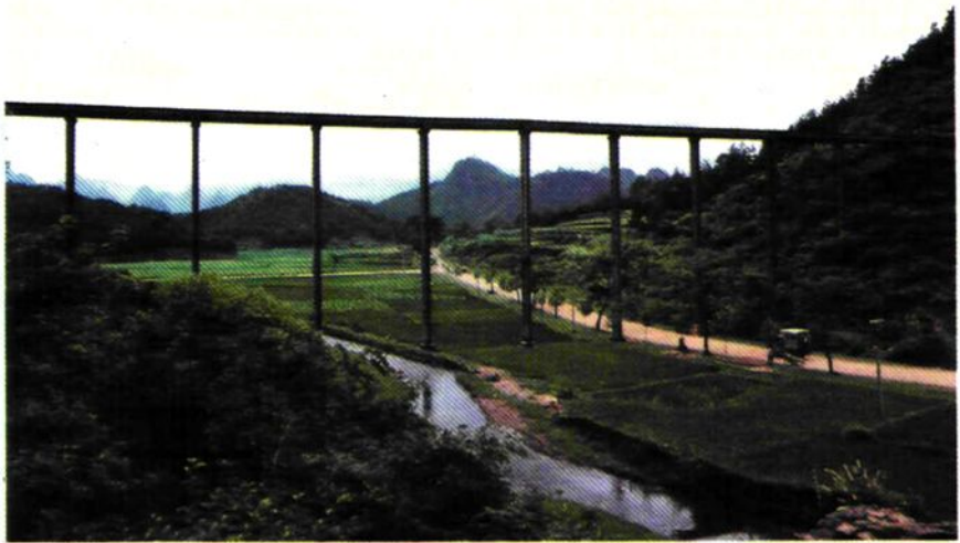
半山水库五指砬渡槽
