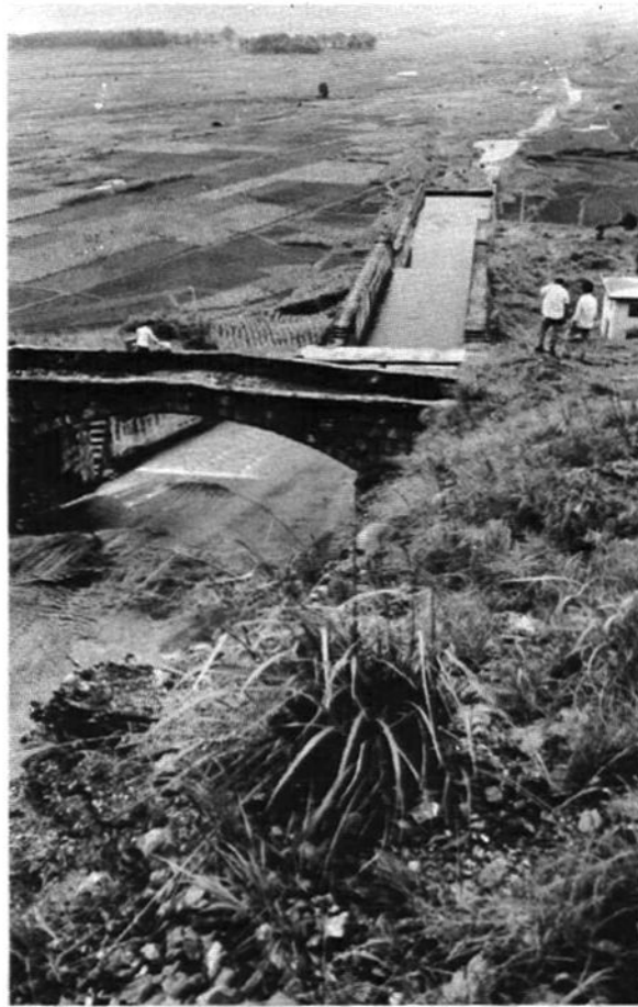
凤仙桥水库溢洪道
