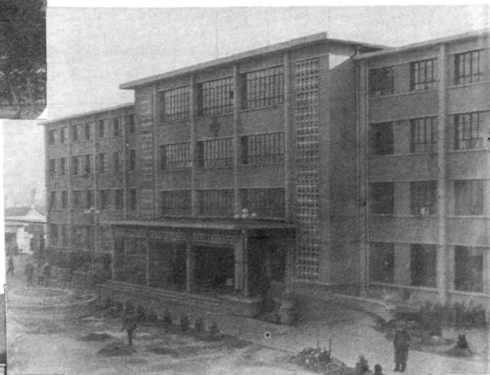
⑧秦皇岛市第二医院门诊楼
