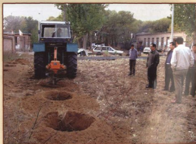
3WG-500型植树挖坑机 在进行挖坑作业
