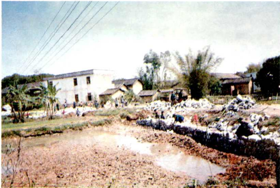
在施工中的盘石公路
