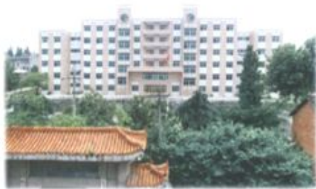
1999年竣工的梅川高中“超人”楼
