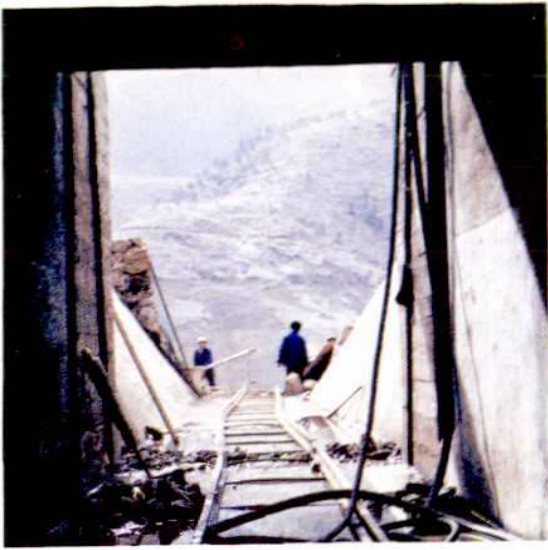
□ 建设中的松花坝高位引水隧道
