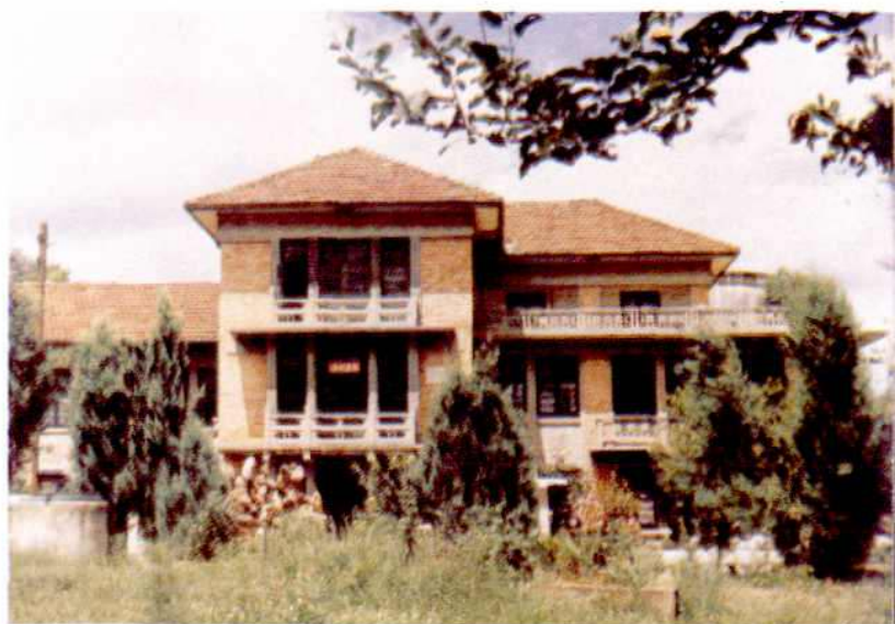
◇二水厂控制楼
