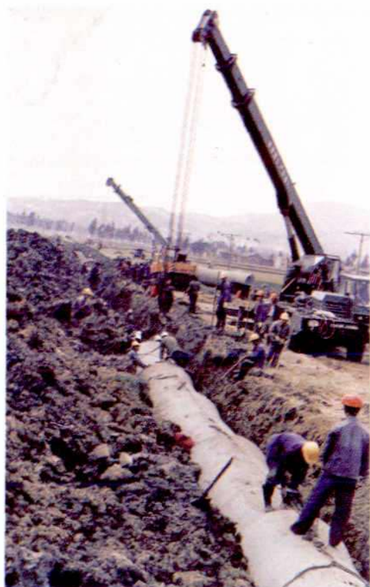
◇松花坝水库至一、二 水厂引水管工地
