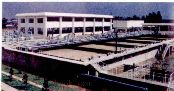
□ 五水厂气浮池
