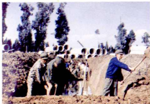
◇人民子弟兵支援公司管道建设
