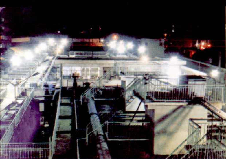
◇扩建后一水厂夜景
