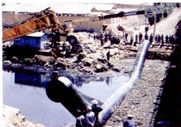
◇大观河沉管工程现场
