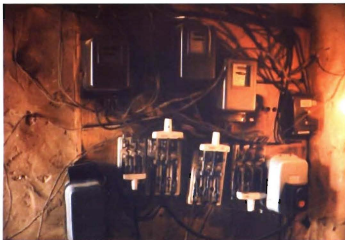
隰县20世纪70年代的单相 电能表安装情况 ▶
