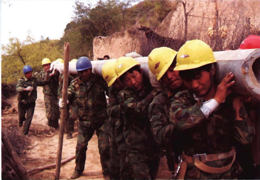
▲ 2006年10月6日“户户通电”工程施工情景
