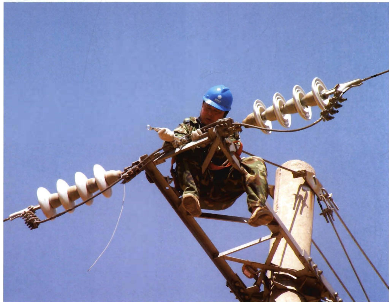
2010年3月，10千伏线路改造
