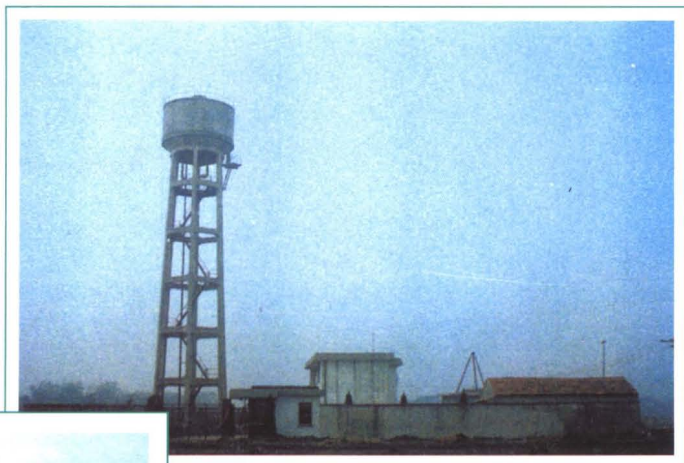
▶ 建于1992年、地处光辉村第六村民小组的干巷镇第一眼深井水塔 (摄于1995年)
