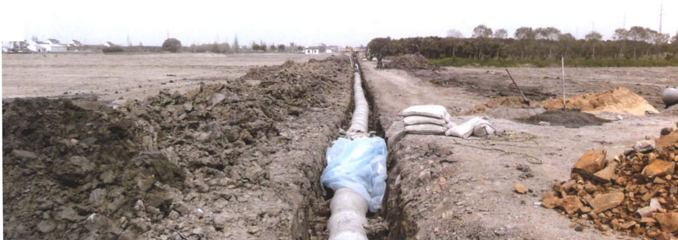
▲ 埋设地下渠道
