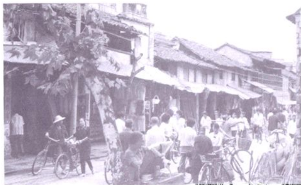
太平东路改造前
