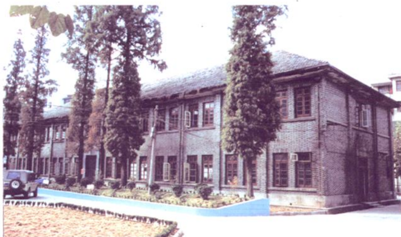
龙游镇人民政府办公楼 (原县人民政府办公楼)
