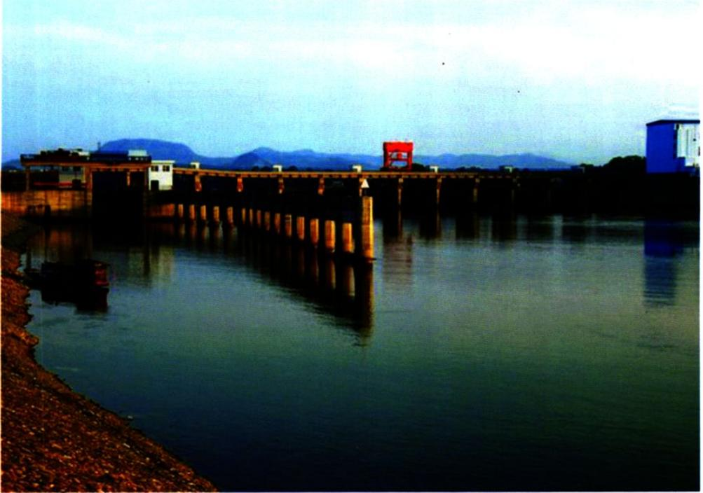
白竹洲水电站位于益阳市桃江县境内资水干流的中游。该工程以发电为主，为资水柘溪水电站下游七级规划中的第五节，枢纽属Ⅲ等中型工程，是一座以发电为主，兼有航运、旅游等综合效益的水利水电工程。坝址位于白竹洲洲头处（洲长约4.5km），河道由白竹洲分为左右两汊，其中左汊为主河道。枢纽总平面布置主要建筑物从左到右依次为：左汊左岸土坝、电站厂房、左汊溢流闸坝、船闸、中洲土坝、右汊溢流闸坝、左岸连接重力坝段。工程由永久建筑物挡水坝，电站厂房为4级建筑物。坝高21.7米，坝长759.73米，年平均流量723M<sup>3</sup>/秒，船闸设计通航吨位为300吨。工程于2008年6月19日正式开工。
