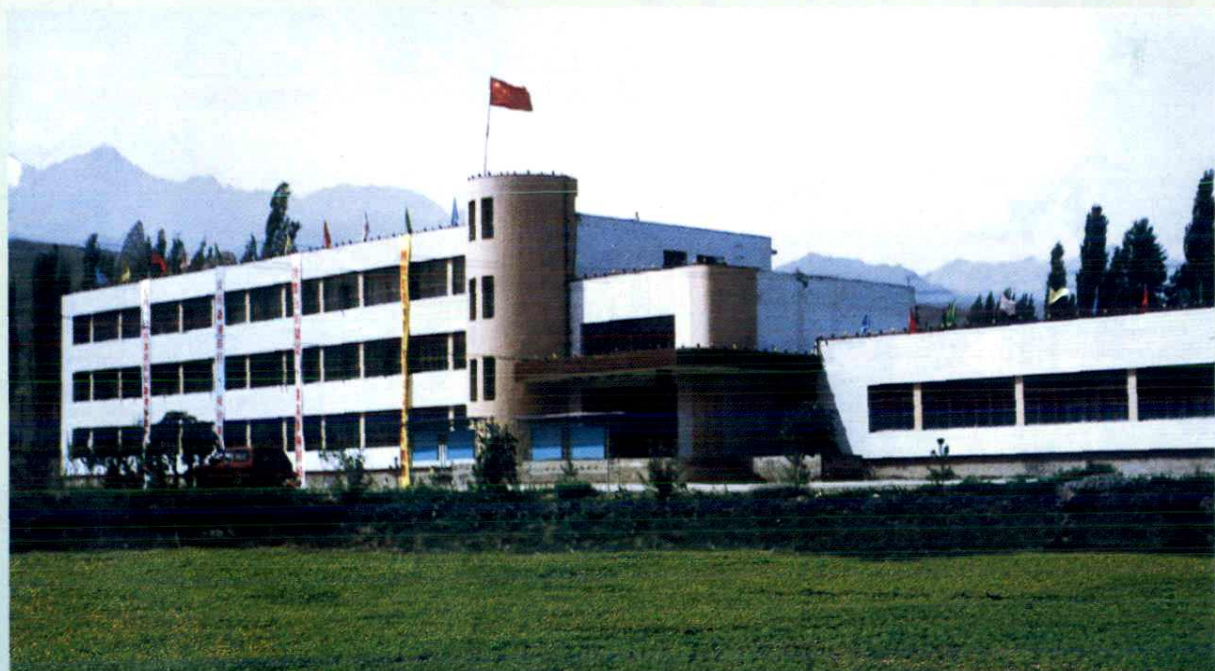
△新建的矿机关办公楼
