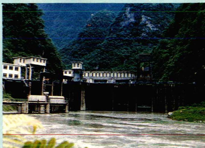
▶ 映秀湾发电厂渔子溪电站
