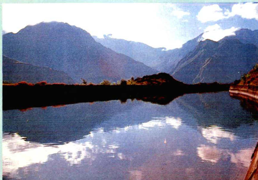
◀ 利用溶洞泉水发电的磨房沟电站水位调节池
