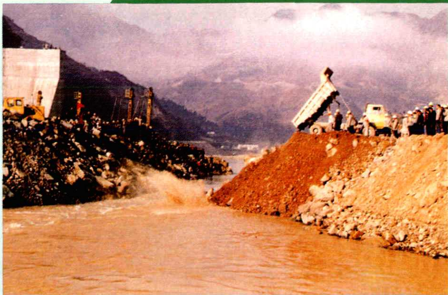
► 建设中的宝珠寺发电厂(总装机容量10万千瓦)
