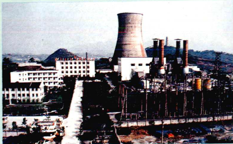
◀ 集资兴建的以天然气为燃料的重庆燃机电厂(总装机容量 10.85 万千瓦)
