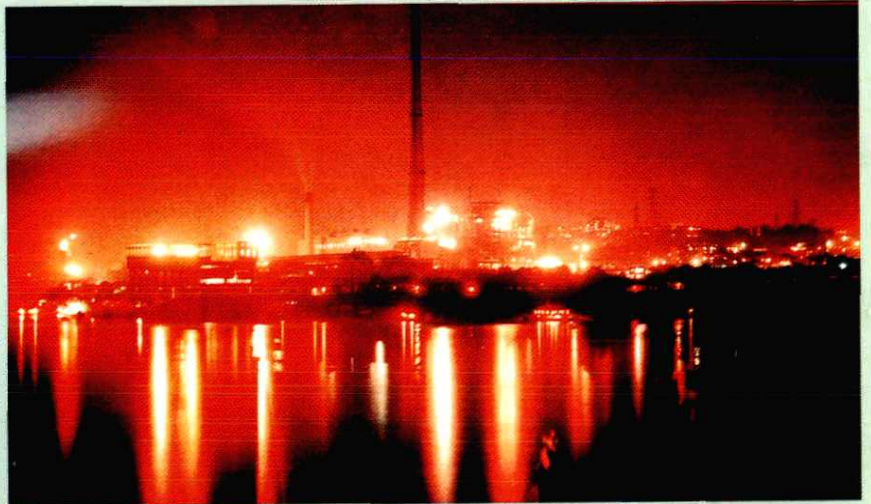
▶1990年四川省最大的火力发电厂—重庆发电厂(总装机容量68.6万千瓦)
