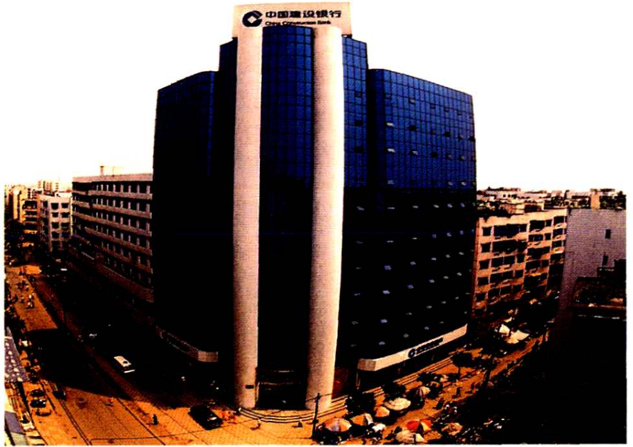
中国建设银行遂宁市分行办公大楼
