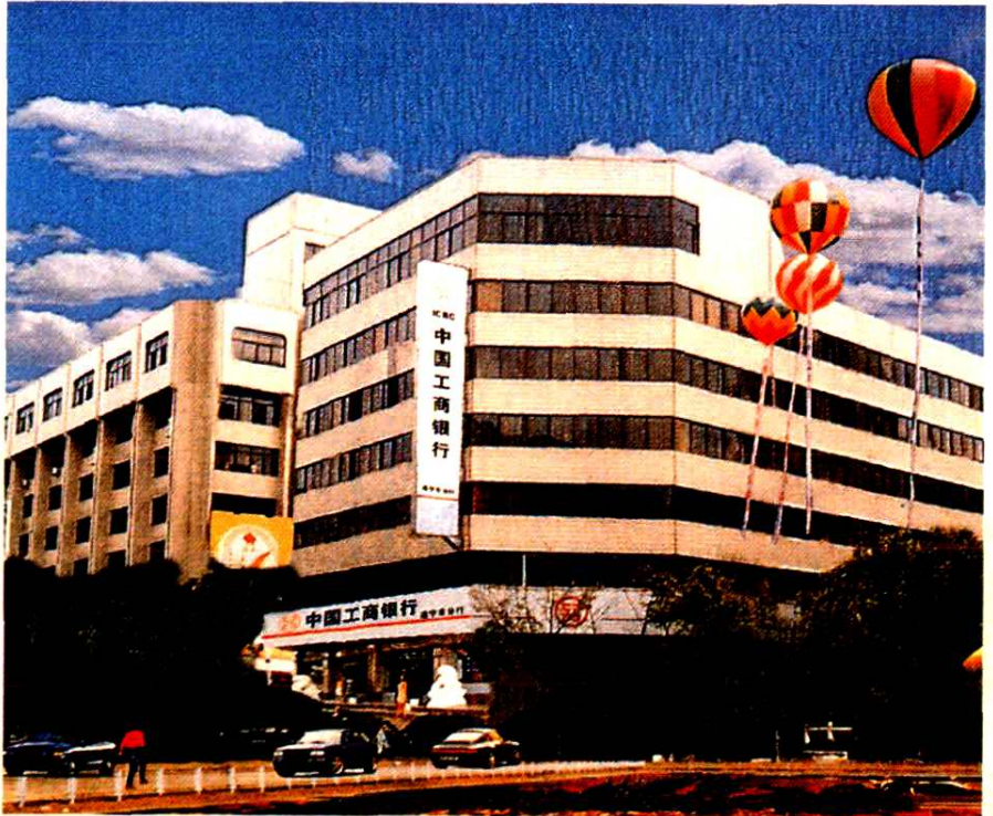
中国工商银行遂宁市分行办公大楼
