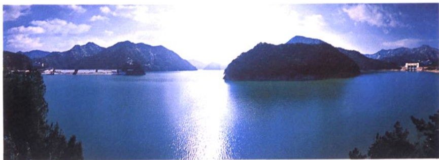
除险加固后的金华市市区安地水库
