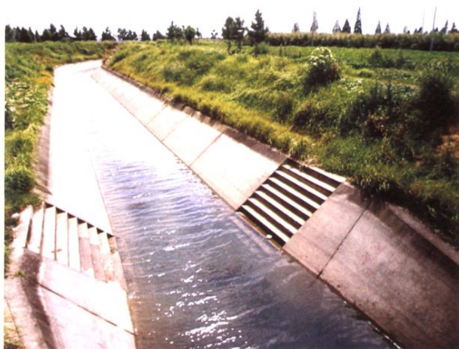
乌溪江引水工程婺城区境内干渠
