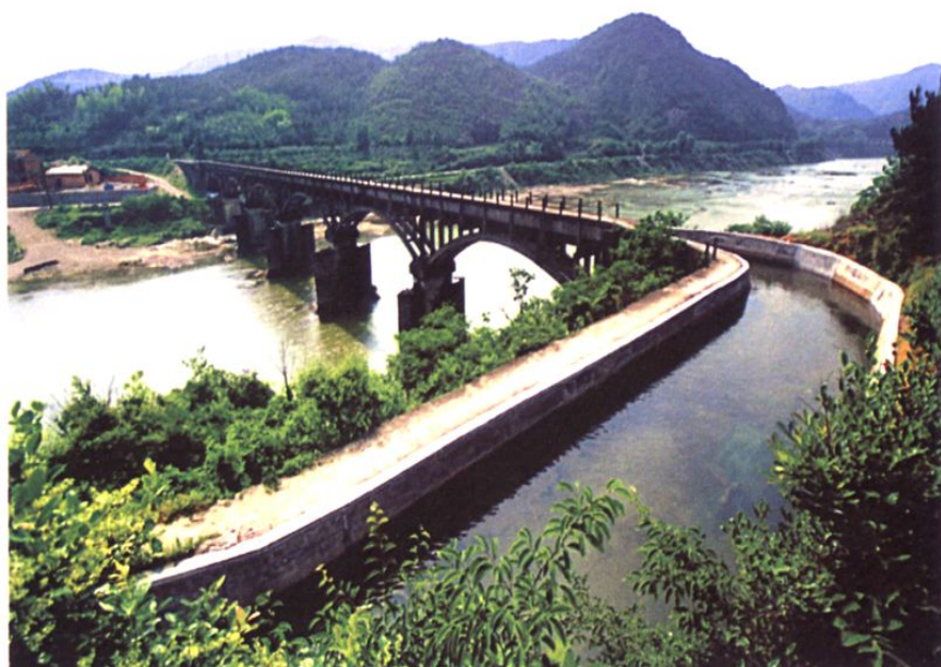
金华市市区安地水库灌区东干渠改造工程
