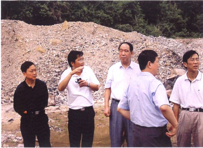
2004年7月5日，中共浙江省委副书记周国富（左三）视察建设中的九峰水库。
