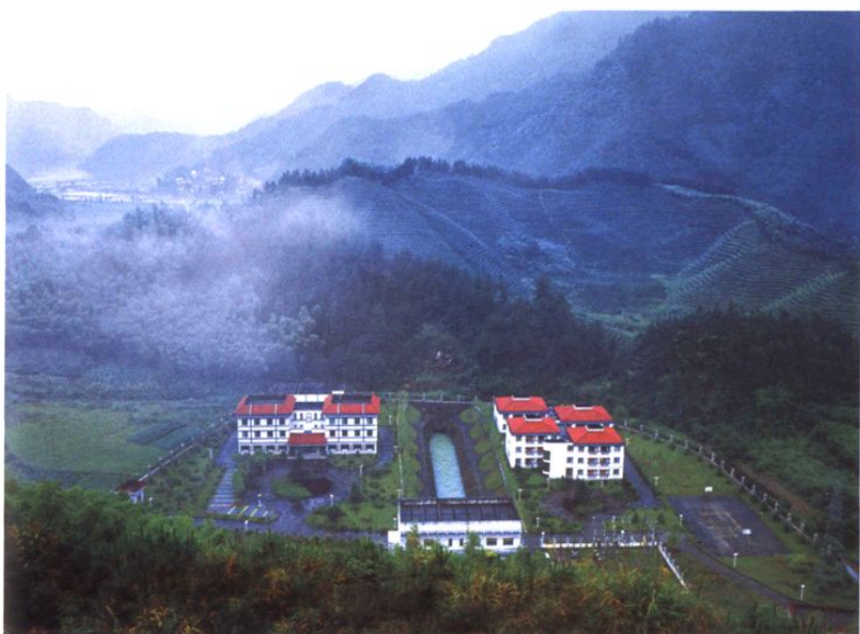
金华市市区沙畈水库二级电站
