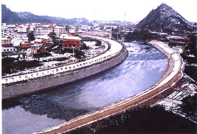
金华市市区梅溪治理工程
