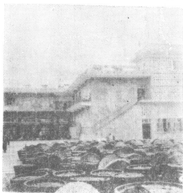
一九八一年新建的郫县犀浦豆油生产车间外景
