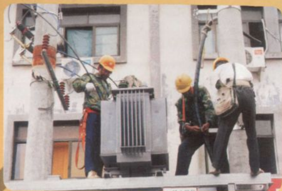
城网改造紧张施工
