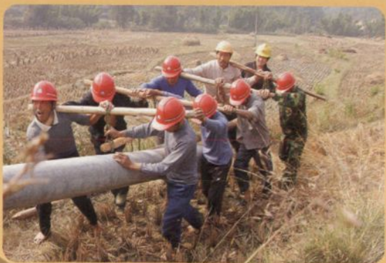
农网改造紧张施工
