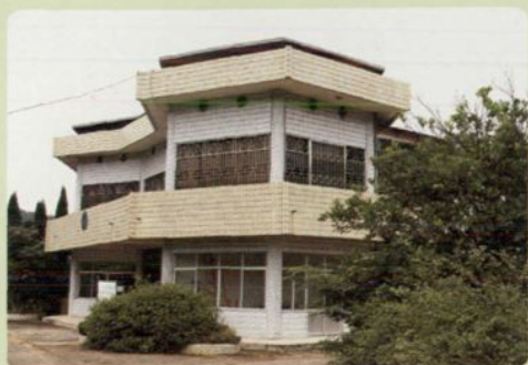
35千伏五云变电站
