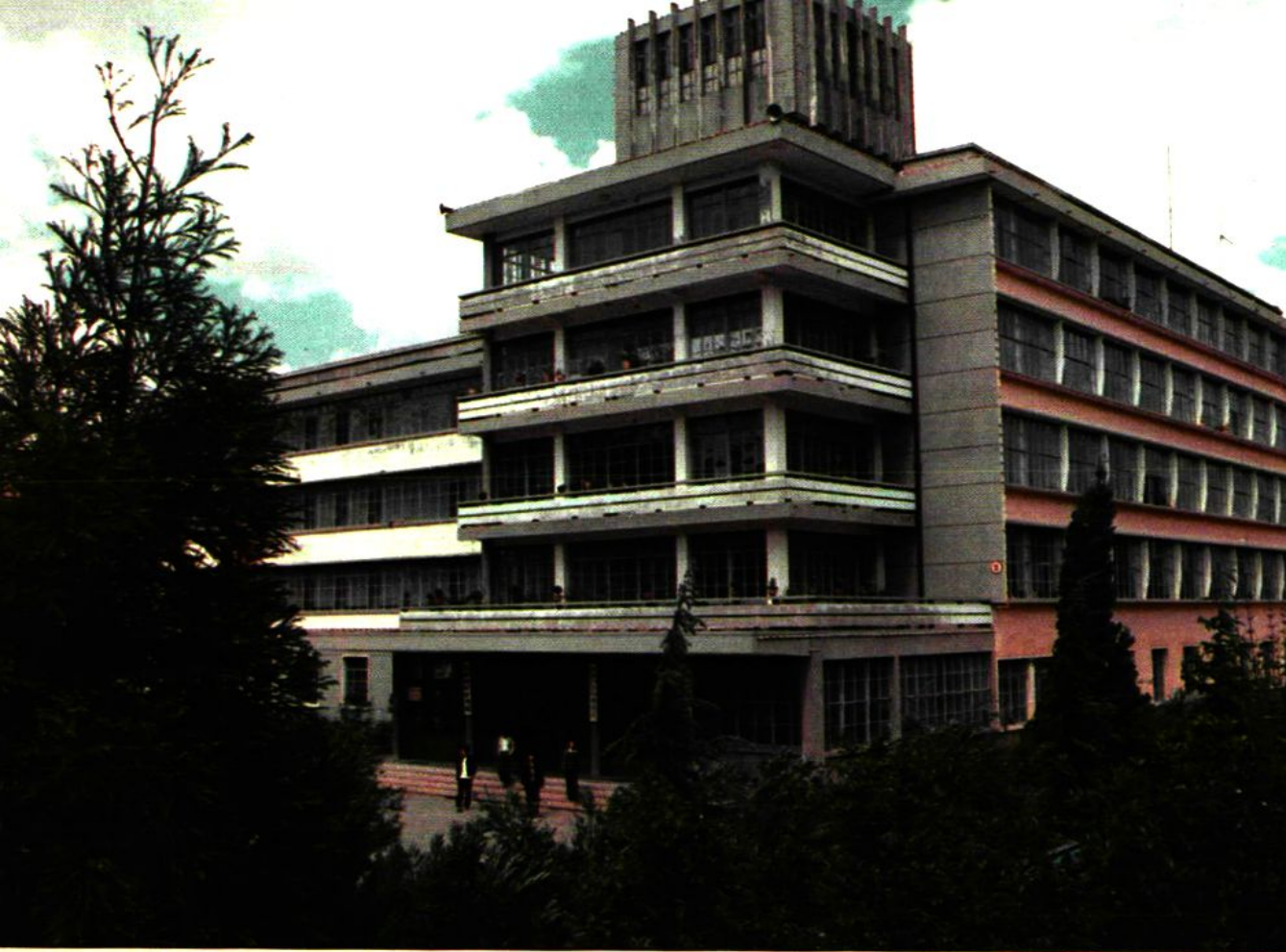
△礦務局機關辦公大樓(1982年建設)
