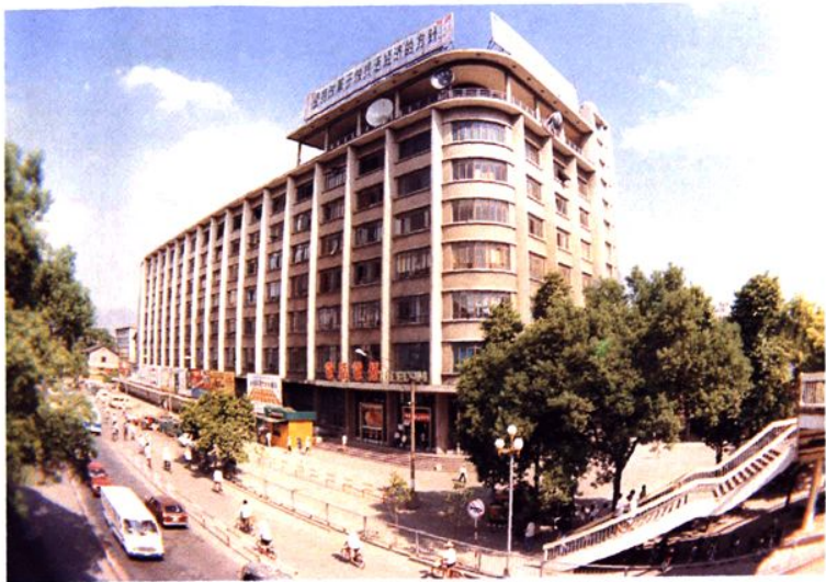
1964年建成的东街口邮电综合大楼，楼高34.8米，总面积16728平方米，成为六七十年代福州市标志性建筑。当时“福州电信局”设于三楼。
