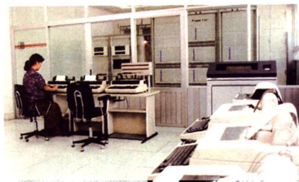
1989年4月开通投产的瑞士哈斯拉T203型程控用户电报及低速数据交换机。
