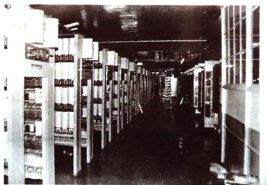
1930年1月1日开通了美国史端乔步进制市话自动交换机1500门。1980年500门史端乔拆下送往大连邮电局使用。该图为大连邮电局拍摄的史端乔自动交换机。
