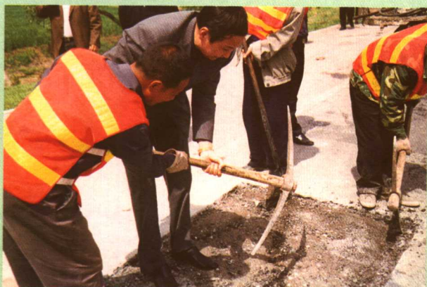
局长朱年有深入施工一线参与养护挖补
