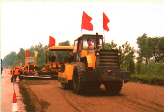
机械化施工现场
