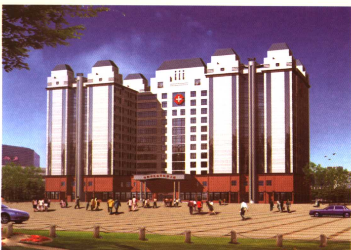
南阳市第一人民医院病房楼
