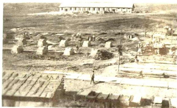
建厂初期生产区
