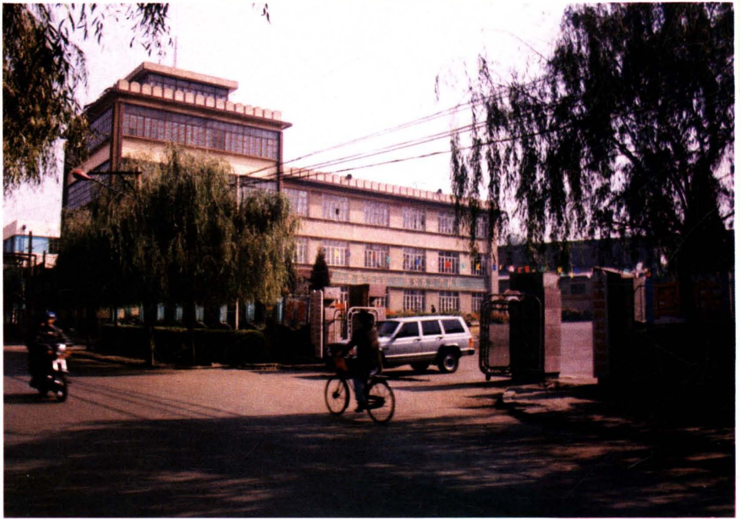
运输部机关办公楼
