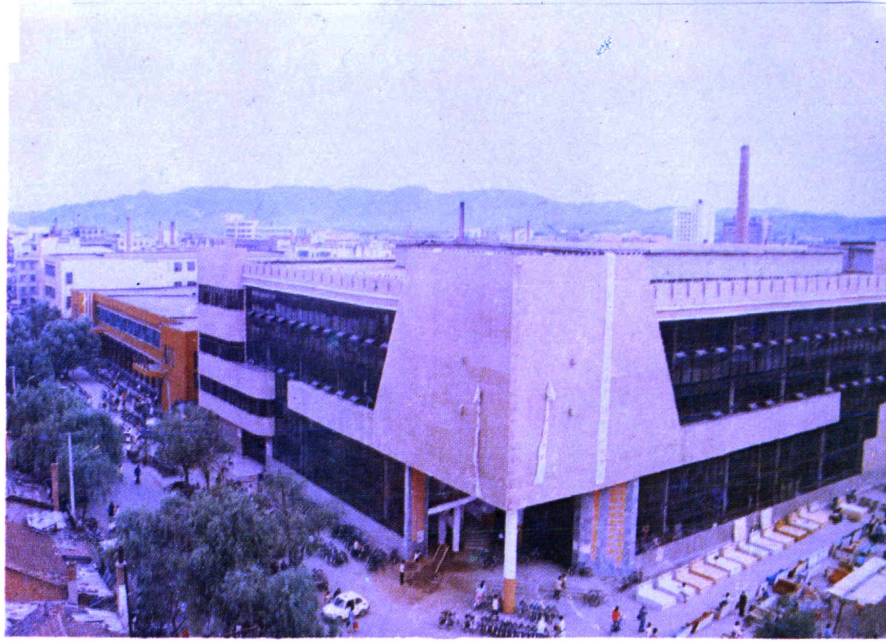
一九八九年九月三十日兴建西市 第三期贸易大楼。
