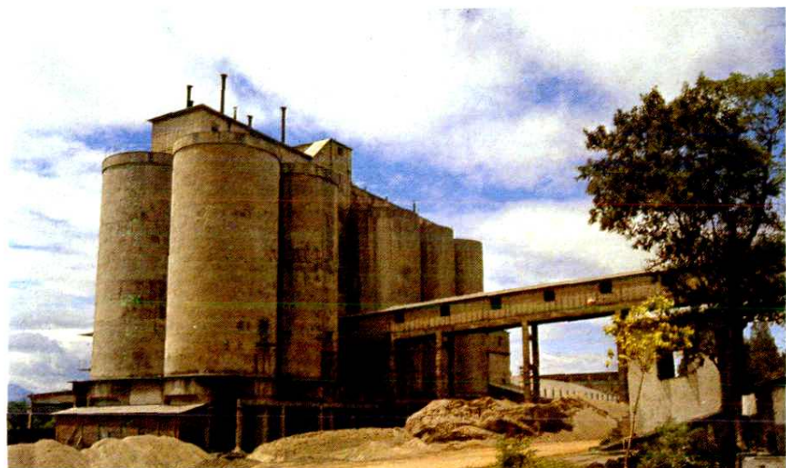
○ 10×22M 个水泥库
