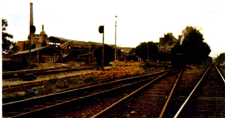
厂铁道专用线
